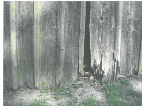
Uszkodzenia drewna wynikające z działania wilgoci i korozji biologicznej w strefie przyziemia.
