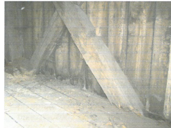
Ubytki drewnianej konstrukcji - zastrzały (ściana południowo - wschodnia).
