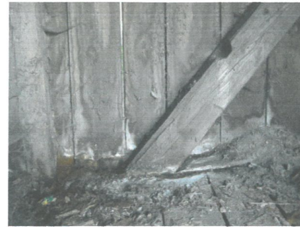
Zniszczenia strefy przyziemia - ściana północno - wschodnia wraz ze zbliżeniem na destrukcję drewna wynikającą z zagrzybienia obiektu.
