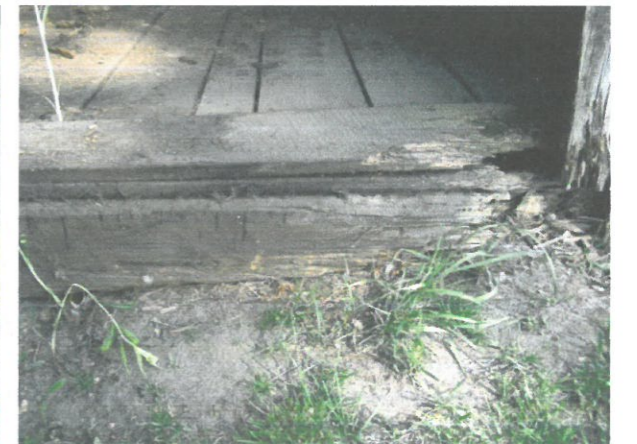
Uszkodzenia drewna wynikające z działania wilgoci i korozji biologicznej w strefie przyziemia.
