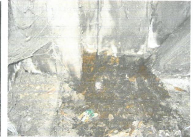
Zniszczenia strefy przyziemia - ściana północno - wschodnia wraz ze zbliżeniem na destrukcję drewna wynikającą z zagrzybienia obiektu.
