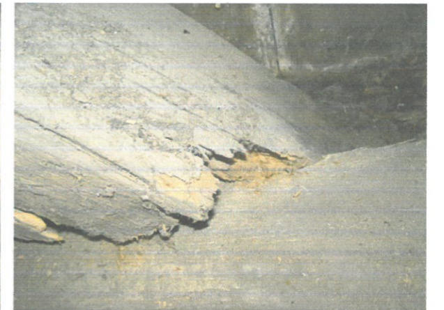
Ubytki drewnianej konstrukcji - zastrzały (ściana południowo - wschodnia).
